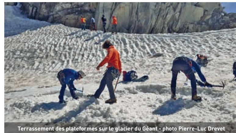
Terrassement des plateformes sur le glacier du Géant - photo Pierre-Luc Drevet
